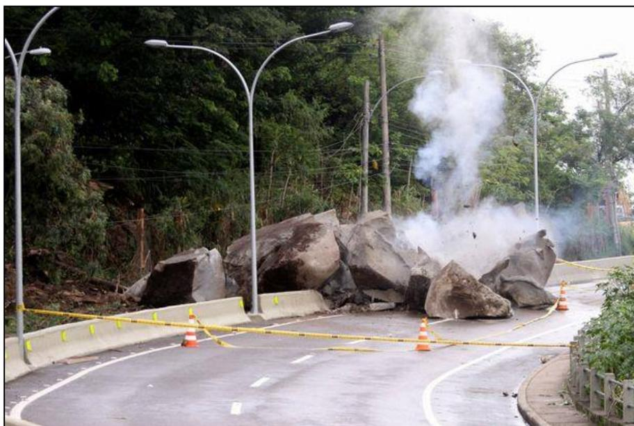
Fotos – Bloco rochoso que bloqueou a via. Foram utilizados explosivos para desmontá-lo.
