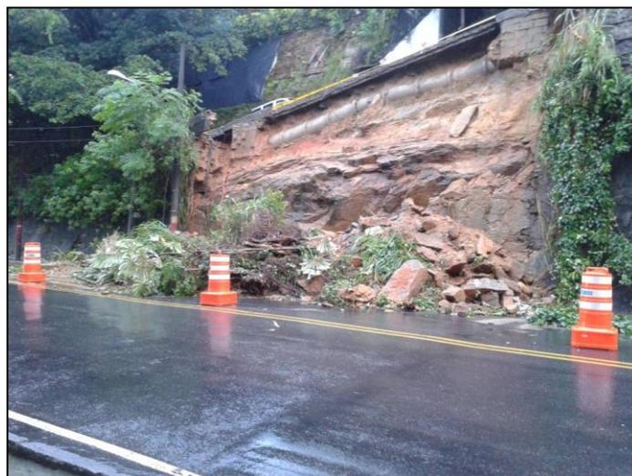
**Figura 4 – Laudo 151/2007 – 21/06/2017** - Ruptura de muro de pedra antigo que arrima o trecho inicial da Ladeira Cerro Corá, um dos principais acessos a Comunidade do Cerro Corá, em face de forte chuva. Verificou-se também queda de árvores sobre a Rua Cosme Velho a jusante e exposição da tubulação de drenagem existente sob a Ladeira Cerro Corá.
