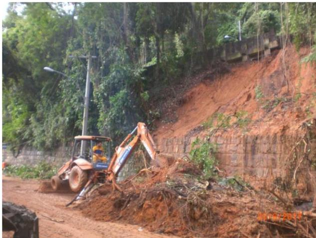
**Figura 3 – Laudo 150/2007 – 20/06/2017** - Talude existente em frente à propriedade de nº 1085 na Avenida Edson Passos no Alto da Boa Vista, tendo a mesma avenida a montante e a jusante. Em face da forte chuva da madrugada, houve deslizamento de material terroso, que se depositou no leito da avenida, impedindo a passagem de veículos. Observou-se também que com o deslizamento houve queda de árvores, que atingiram a rede elétrica local.
