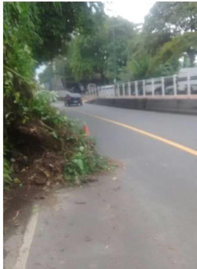
**Figura 1 – Laudo 109/2007 – 29/04/2017** - Deslizamento de capa de solo sobre perfil rochoso oriundo de talude a montante da Av. Niemeyer, próximo ao nº 230, onde existem moradias implantadas a montante.
