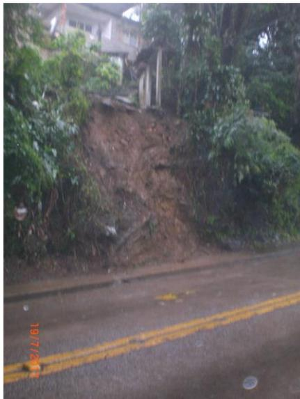
**Figura 5 – Laudo 239/2007 – 19/07/2017 - Talude de corte executado para abertura da Estrada de Furnas. Constatou-se no local deslizamento de material terroso proveniente do talude, em face do forte evento chuvoso da madrugada, atingindo o leito do logradouro. No momento da vistoria o material que obstruía parcialmente a pista já havia sido removido pela COMLURB.**
