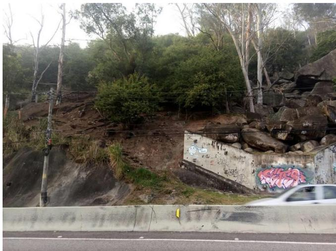
**Figura 2 – Laudo 133/2007 – 29/05/2017** - Deslocamento de bloco de rocha oriundo de talude existente a montante da Av. Menezes Cortes, pista sentindo Grajaú que cruzou a pista de automóveis e ficou depositado junto à mureta divisória.
