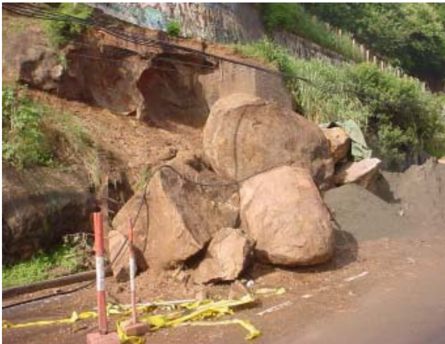
Tombamento de blocos de rocha em talude de corte
