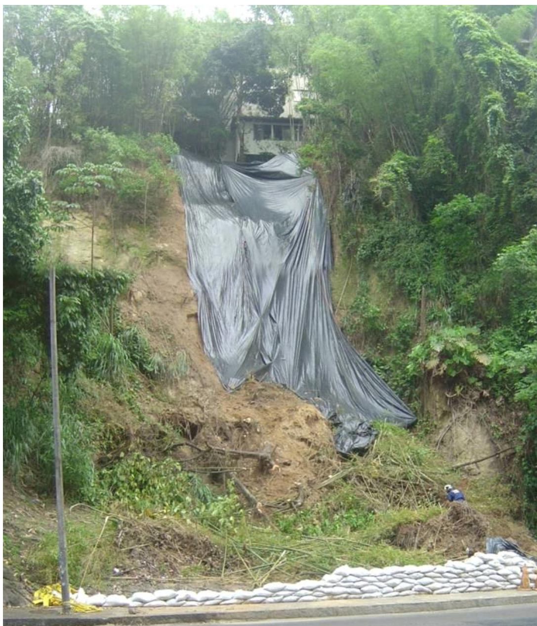
Escorregamento Planar de solo coluvionar/residual presente na crista do talude rochoso
