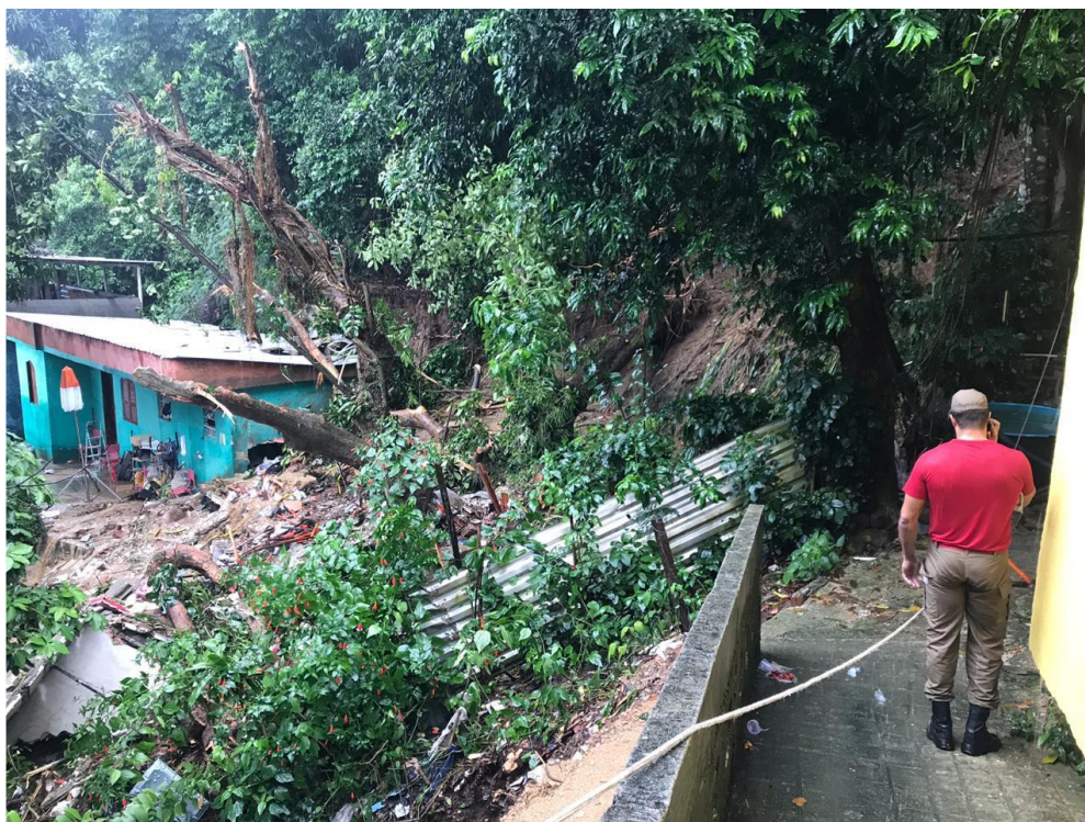
Figura 9 – Acidente na comunidade da Babilônia. Fonte: Fundação Geo - Rio.
