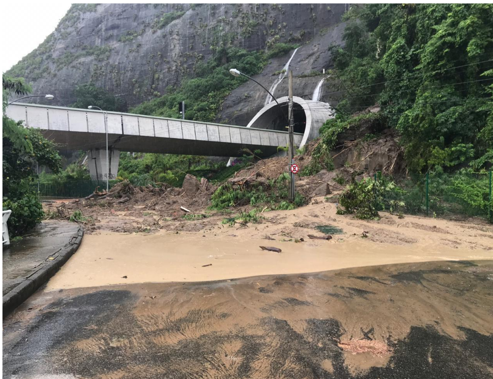
Figura 11: Escorregamento que interditou totalmente a estrada da Barra da Tijuca. Fonte: Fundação Geo - Rio.
