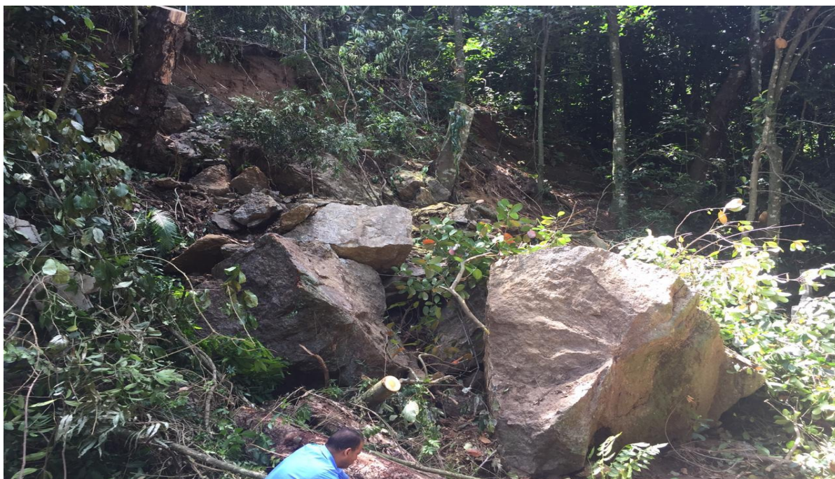
Figura 6: Escorregamento de solo e blocos a montante da via. Fonte: Fundação Geo - Rio.
